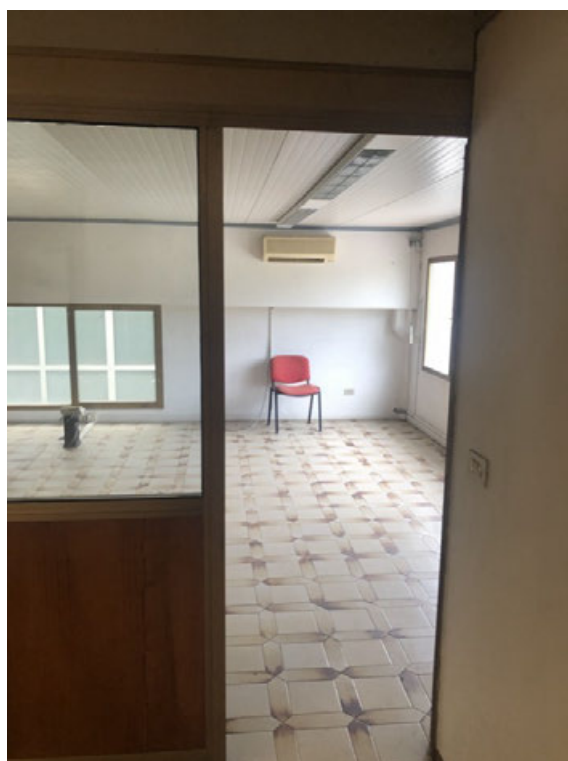
Fotografia A.18 - Corpo A - Uffici PP
