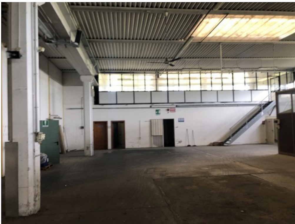
Fotografia A.37 - Corpo A - Capannone particolare scala accesso piano primo stanza blocco B
