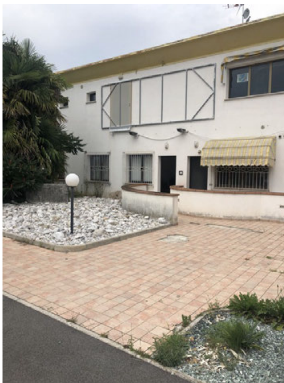
Fotografia A.6 - Ingresso uffici e appartamento lato Ovest
