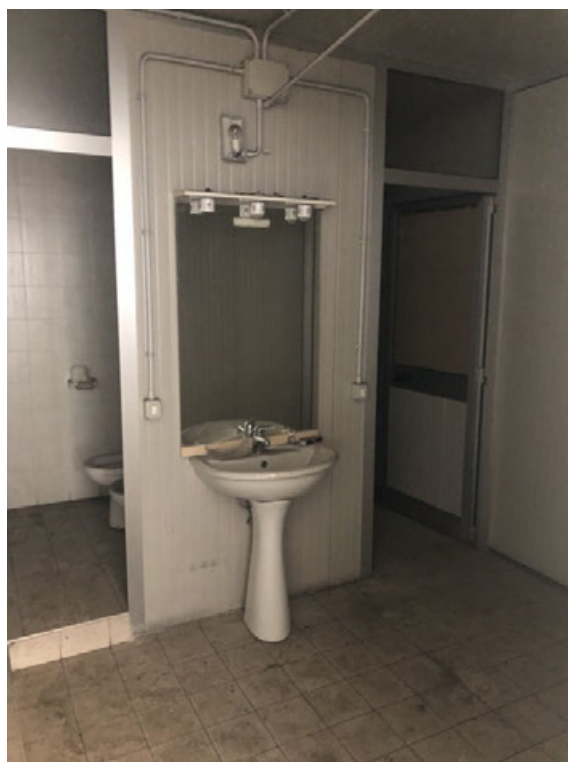
Fotografia A.33 - Corpo A - Capannone - particolare servizi igienici uomini blocco D
