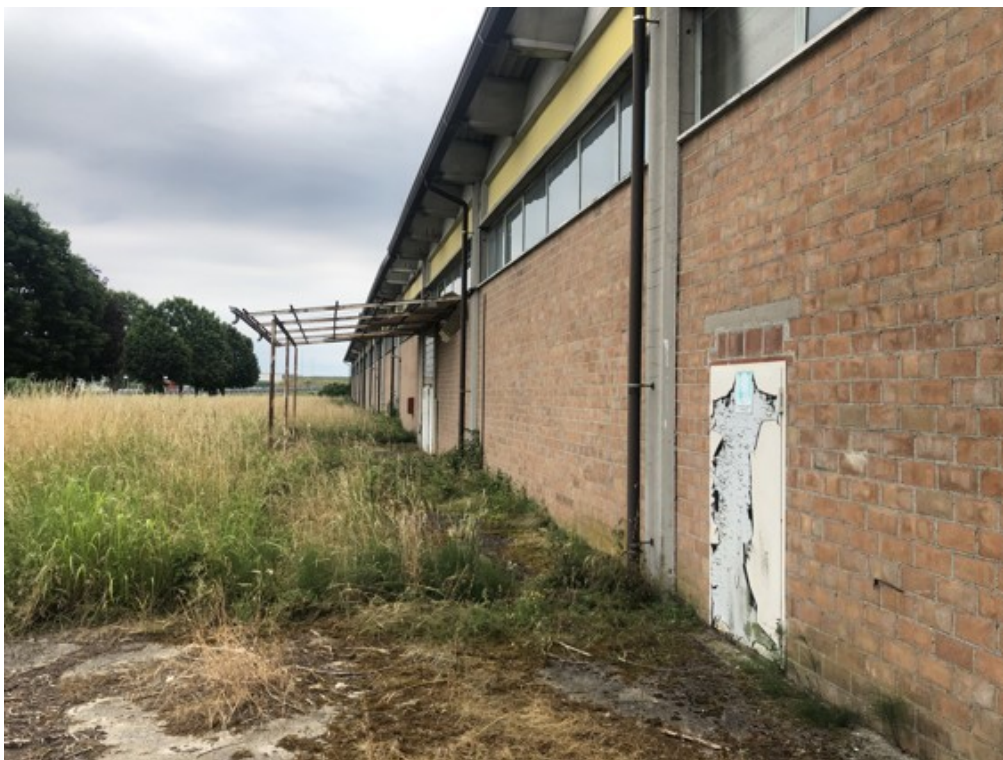
Fotografia A.7 - Corpo A - Prospetto Nord
