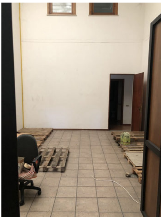
Fotografia A.41 - Corpo A - Particolare androne e porta accesso appartamento alloggio custode
