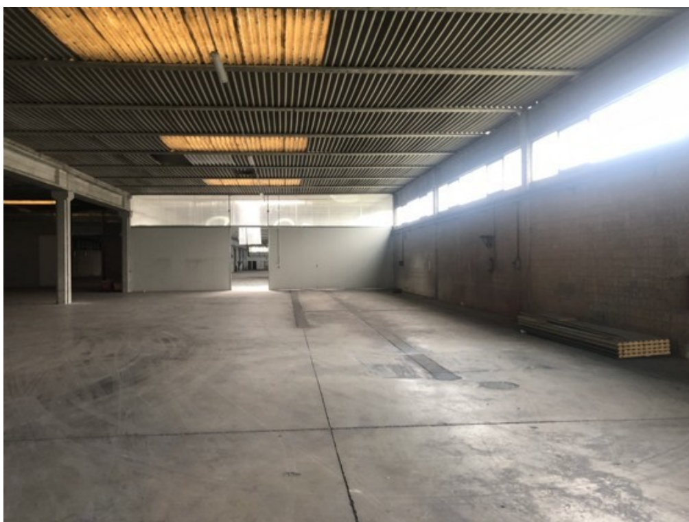
Fotografia A.24 - Corpo A - Capannone - parete prefabbricata con porta scorrevole
