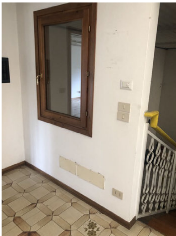
Fotografia A.16 - Corpo A - Arrivo scala Uffici PP
