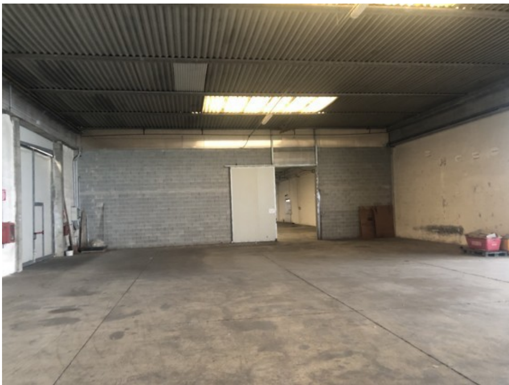
Fotografia A.25 - Corpo A - Capannone - Parete muratura con porta scorrevole
