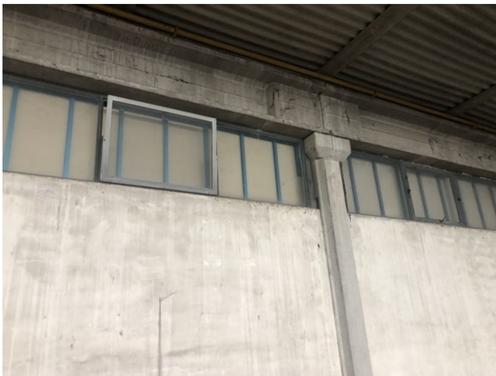
Fotografia A.36 - Corpo A - Capannone - particolare finestrature su fabbricato 893
