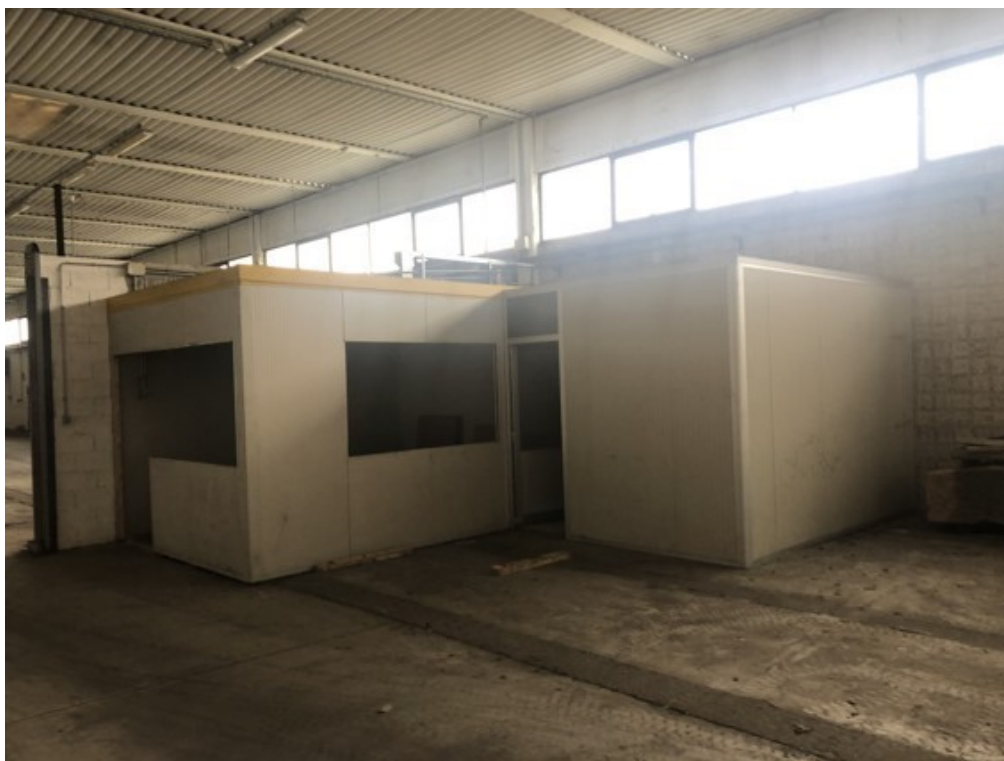
Fotografia A.34 - Corpo A - Capannone - particolare blocco D
