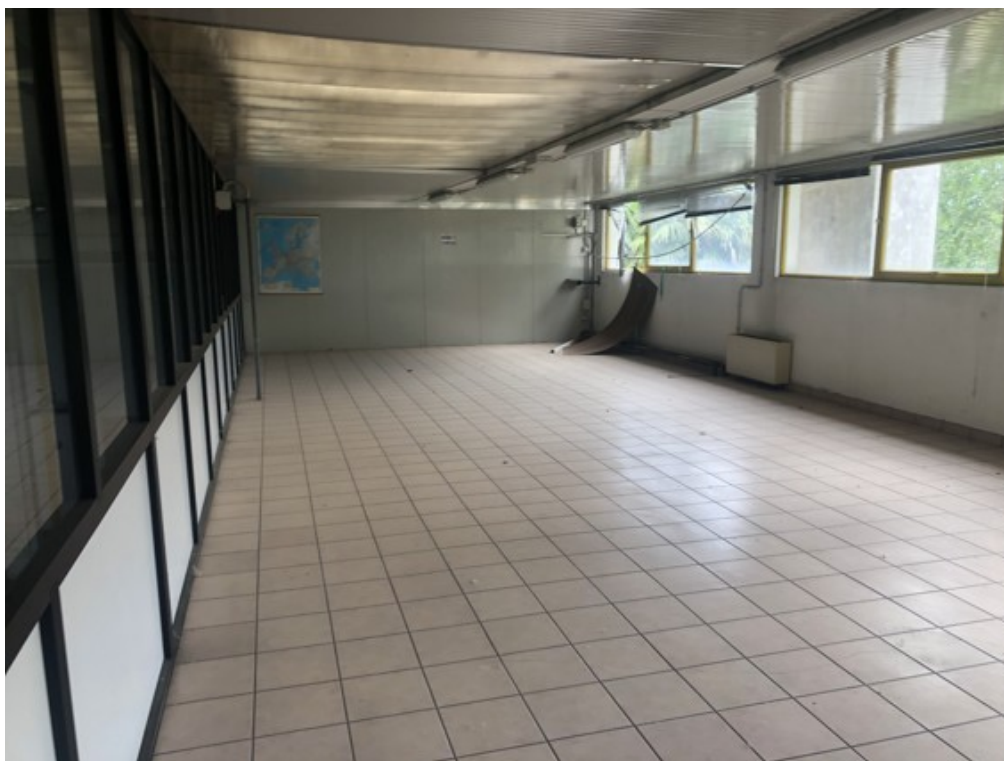
Fotografia A.40 - Corpo A - Capannone - particolare stanza PP blocco B
