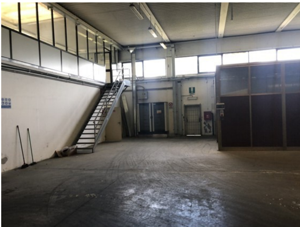
Fotografia A.38 - Corpo A - Capannone - particolare scala accesso piano primo blocco B
