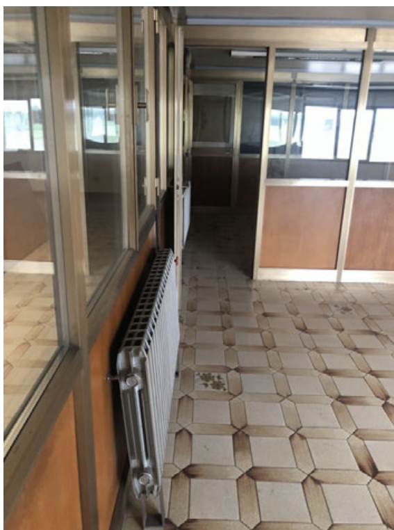
Fotografia A.19 - Corpo A - Uffici PP
