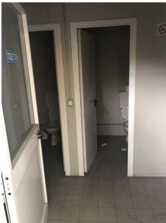
Fotografia A.32 - Corpo A - Capannone - particolare servizi igienici donne blocco D
