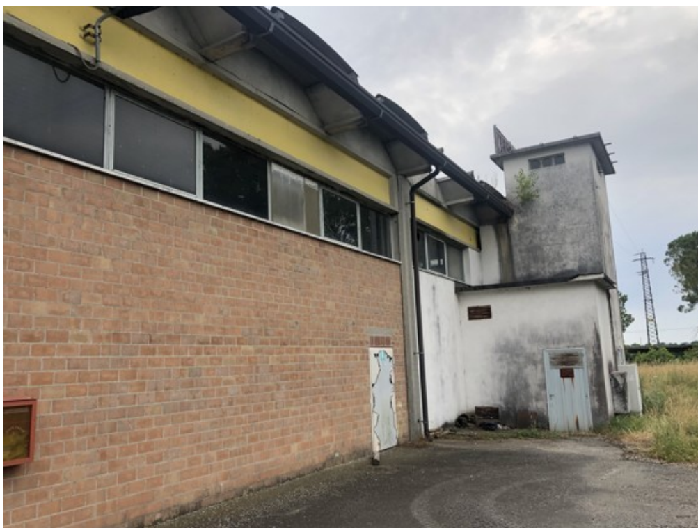
Fotografia A.8 - Corpo A - Prospetto nord - cabina enel
