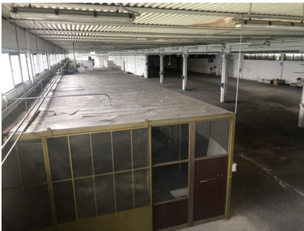
Fotografia A.23 - Corpo A - Capannone vista dall'alto - Officina blocco C
