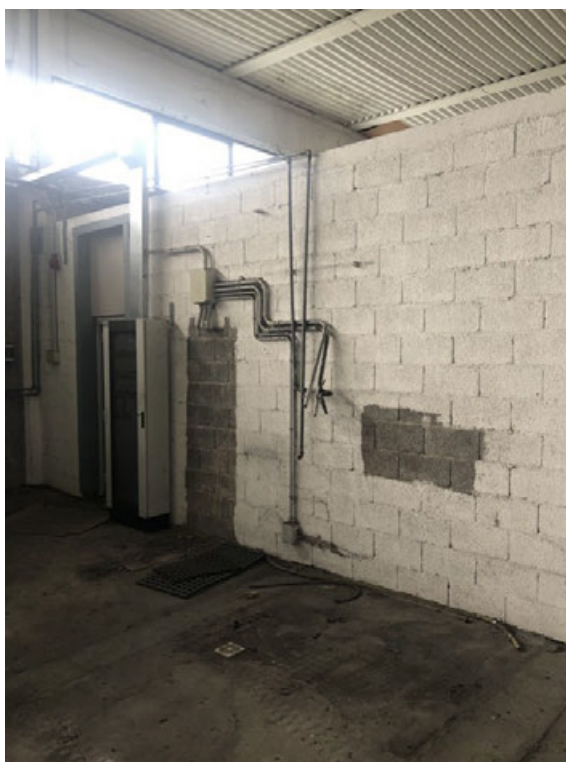
Fotografia A.31 - Corpo A - Capannone - particolare blocco D
